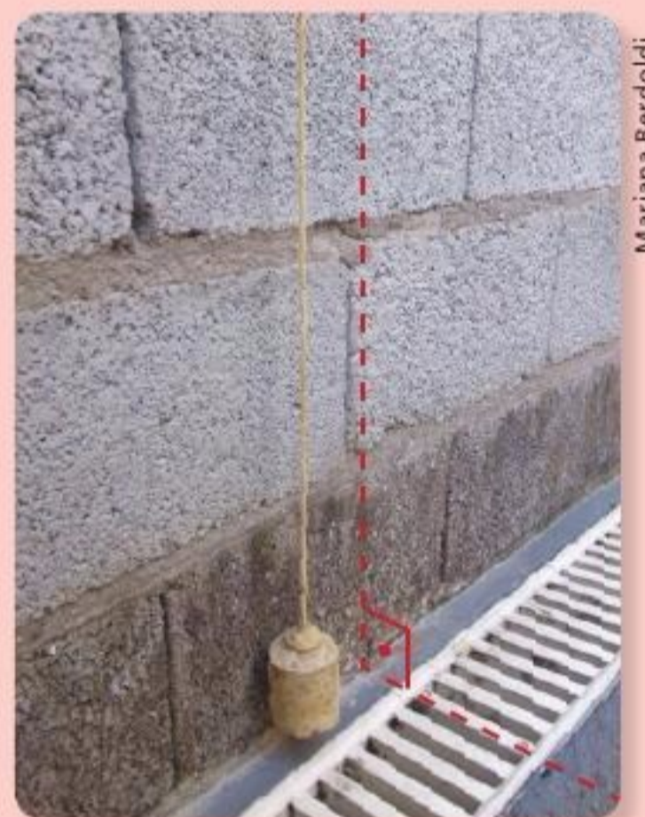
Uma parede no prumo e aquela que forma ângulo reto com o nível horizontal do piso.
