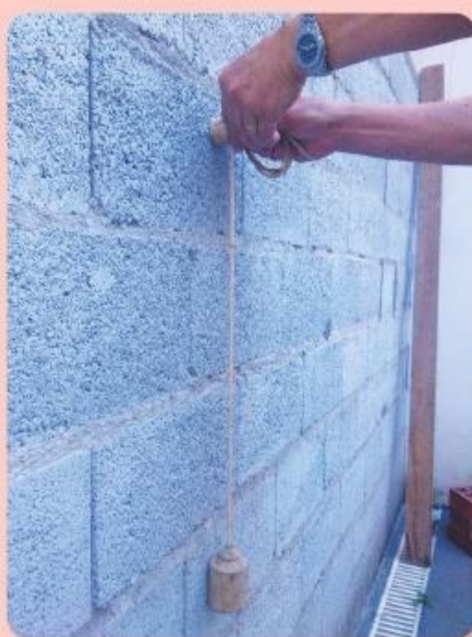
Uma parede no prumo e aquela que forma ângulo reto com o nível horizontal do piso.
