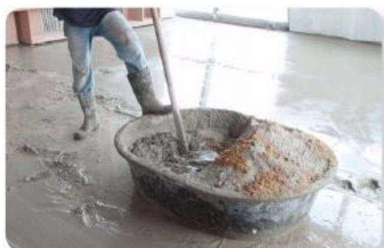
Pedreiro preparando massa.
