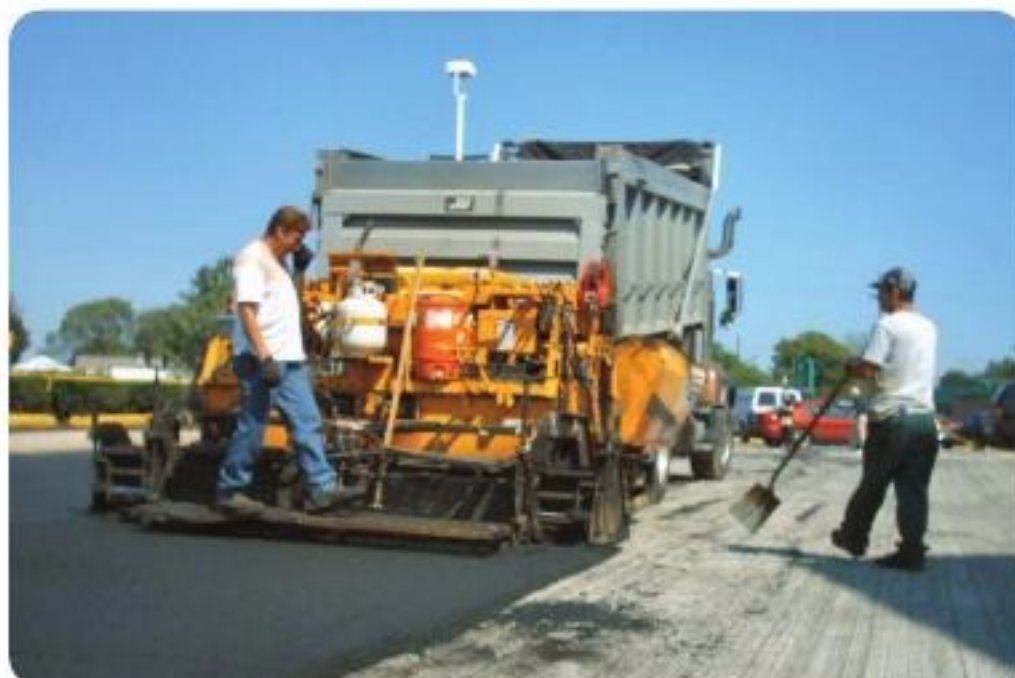
Operários trabalhando em pavimentação de rodovia.
